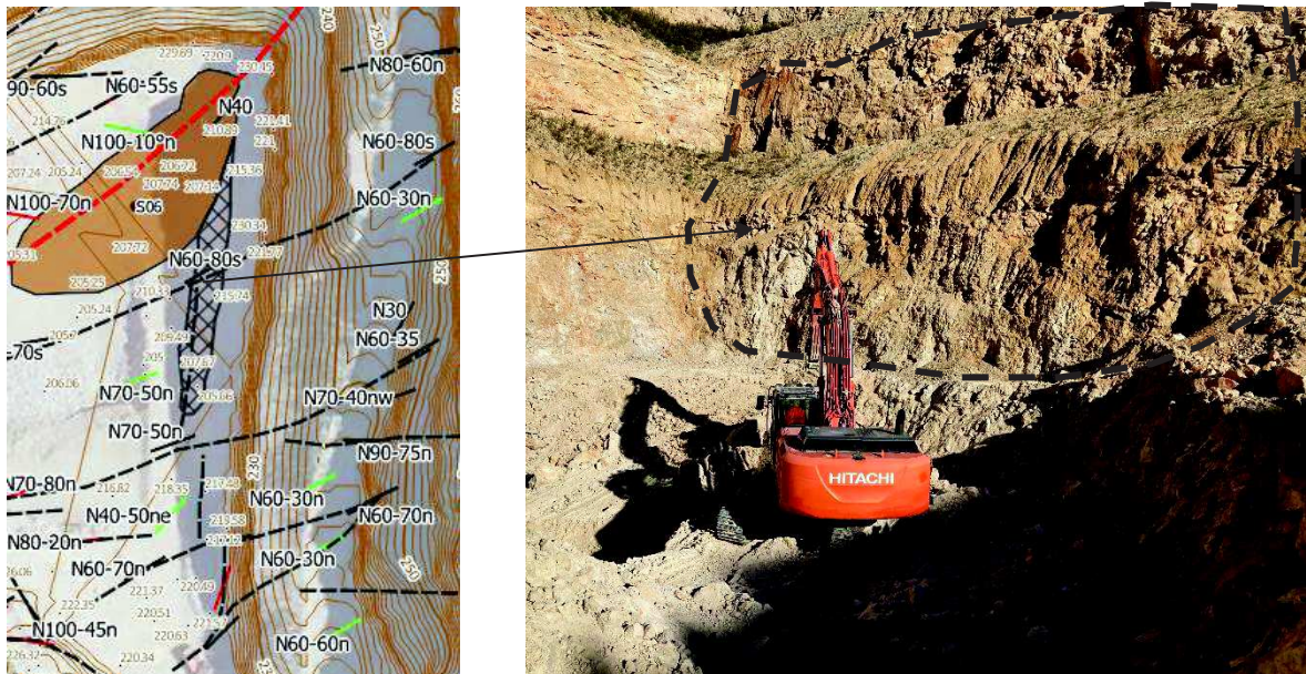
Figure 18 : Front très fracturé (brèche)
