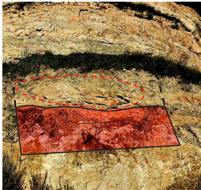
Figure 13 : Plan N60-50°S (lisse et argileux), gradin 225
