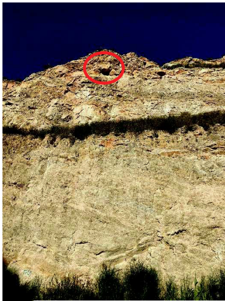
Figure 14 : Masse instable gradin 250, environ 2m 3
